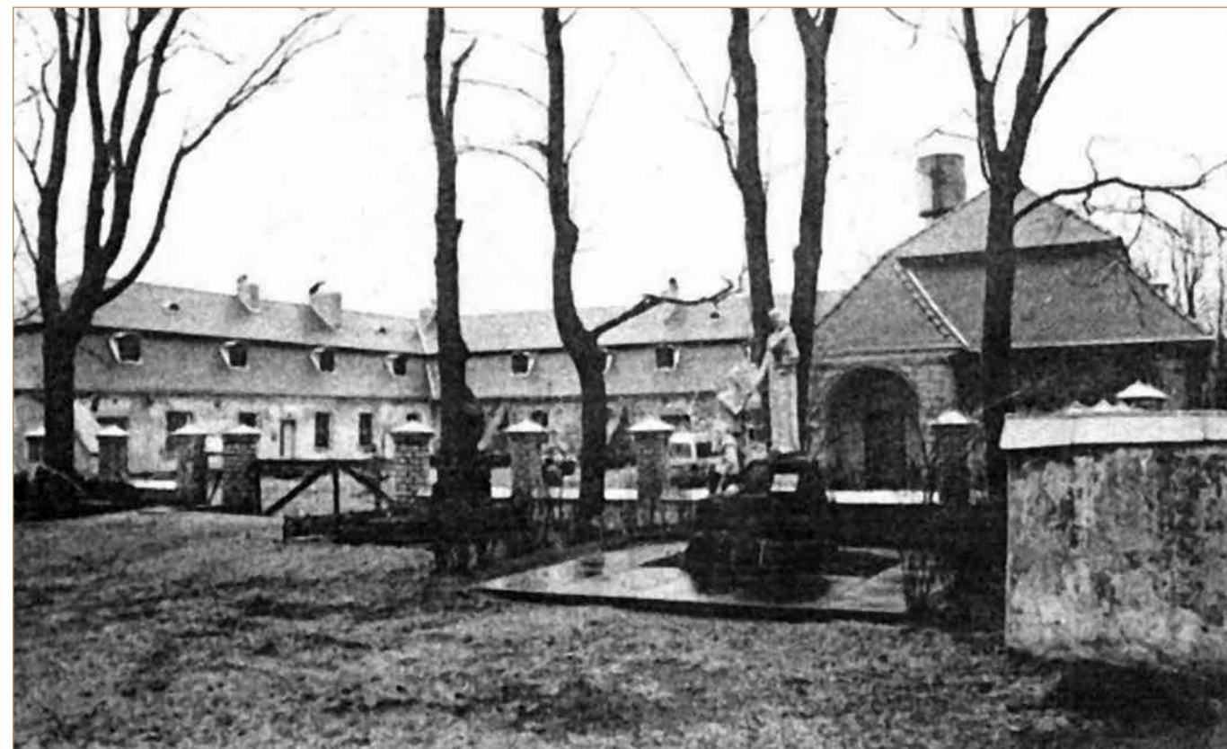
Buvęs Bernardinų vienuolynas po restauracijos. 1994.
